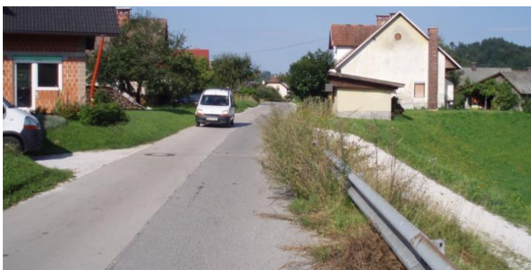
Slika 6. Pešec (kolesar) je primoran hoditi (voziti) v vozišče več kot 1 m od roba, očistiti vozišče ali postaviti oznako zoženje vozišča
